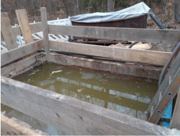
Sanierung der Wasserleitung vom Schmausenbuck nach Zabo
