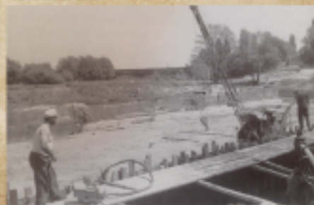
1968 Einarbeiten zum neuen Bad, Quelle Mitte-Jungblatt 2007, Heft August, S. 31
