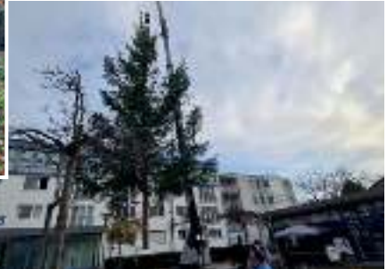
Per Krank wird der Baum in die geöffnete Bodenhöhle gehoben.
