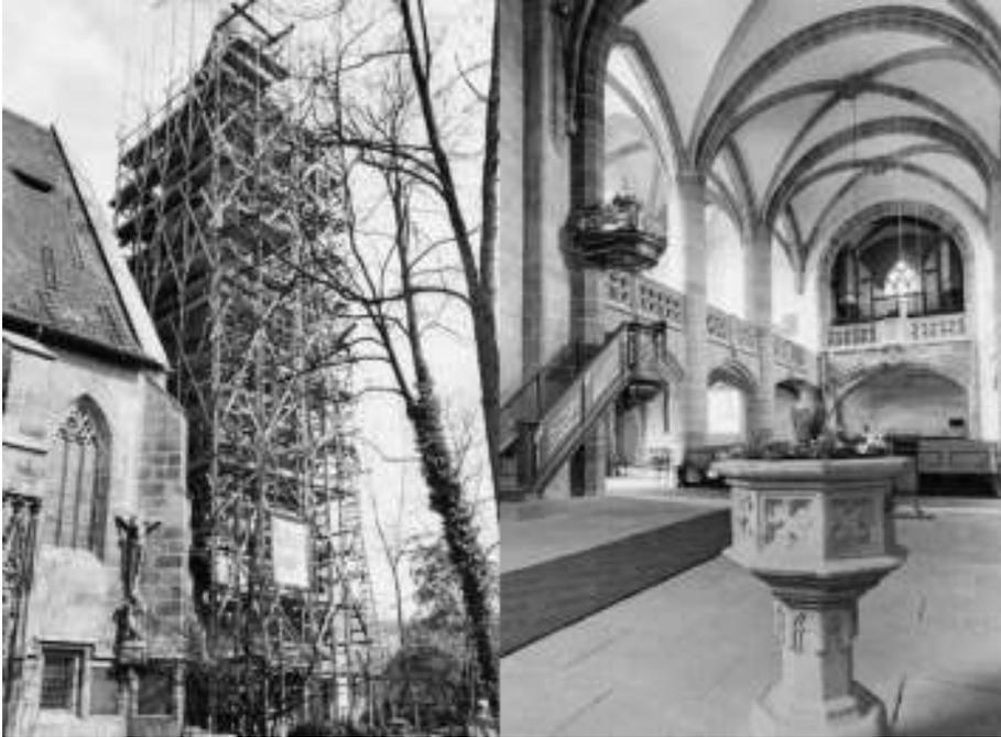
*Der hochaufragende Turm verschwindet fast vollständig hinter den Gerüsten (links). Seine Sandsteinfassade soll erneuert werden; verwitterte Steine werden ersetzt, die Backsteine verputzt. Im Kircheninnern leuchten die Farben der Barockkanzel. Alle Schiffe sind frisch verputzt, unter dem Westchor wurde eine die Harmonie störende Steinbalustrade entfernt (rechts). Foto: Gerardi*
