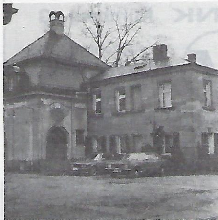
Dieses Haus (Freiligrathstraße Nr. 29) ist das ehemalige Rathaus der Gemeinde Mögeldorf. Es wurde 1886 erbaut. Seit der Eingemeindung Mögeldorfs nach Nürnberg (1. 1. 1899) diente es als Polizeiwache (bis ca. 1938) dann zu Wohnzwecken.
