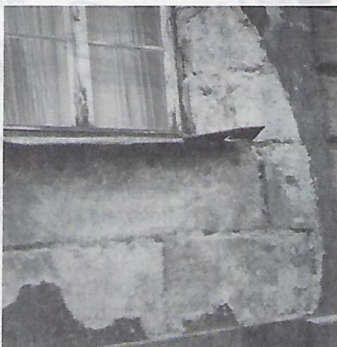
Der Putz des Hauses Laufamholzstraße 9 („alte Noris“) wurde teilweise abgeschlagen. Darunter kam Sandsteinmauerwerk hervor. Da der wilde Wein entfernt werden mußte, sieht das Bauwerk im Moment ziemlich „gerupft“ aus.
