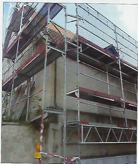
Der Freitagshof wird renoviert.
