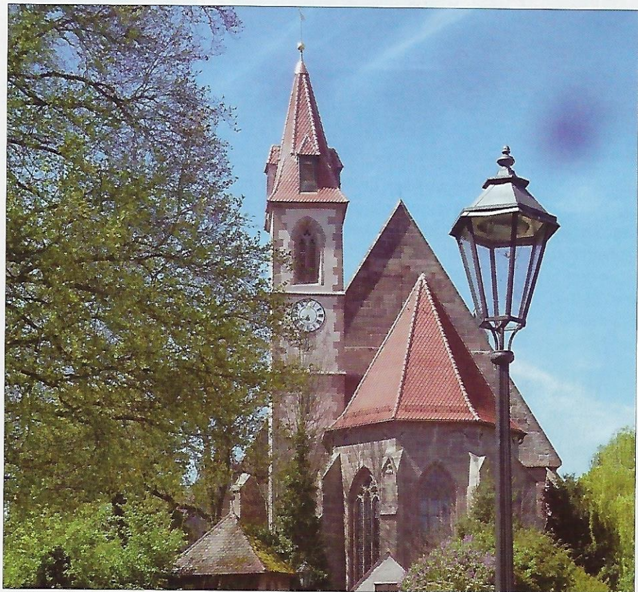
Und endlich gerüstfrei!
