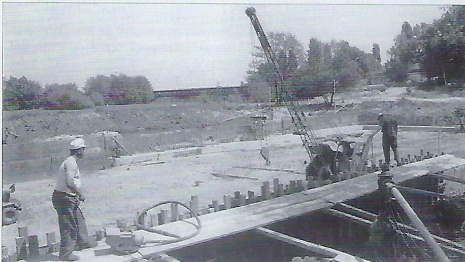
*Olympiamaß: Die beiden Becken haben die für Wettkämpfe erforderlichen 50 mal 25 Meter. Die ersten Betonwände stehen bereits.*
