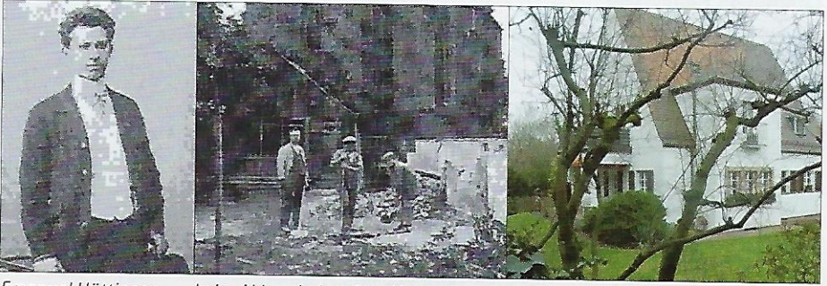
Emanuel Hüttinger beim Abbruch des alten Hauses und das neue Haus heute.
