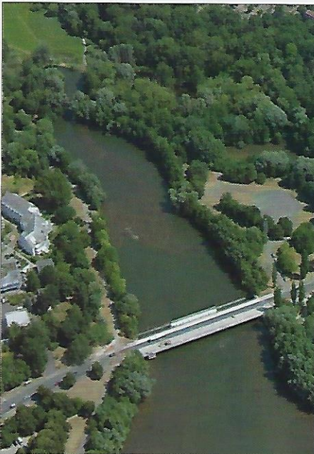
Sandfang und Wehr an der Flusstraße.
