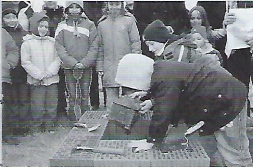
Unser Foto zeigt die fleißigen Megilokinder beim Einmauern des Grundsteins
