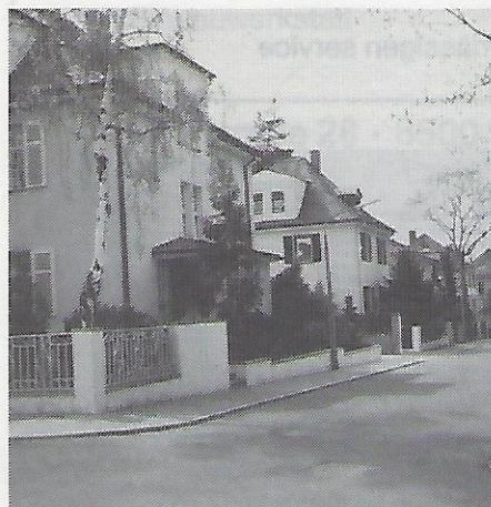
Die großen Häuser auf der Südseite der Kapferstraße wurden sehr ansprechend renoviert.
