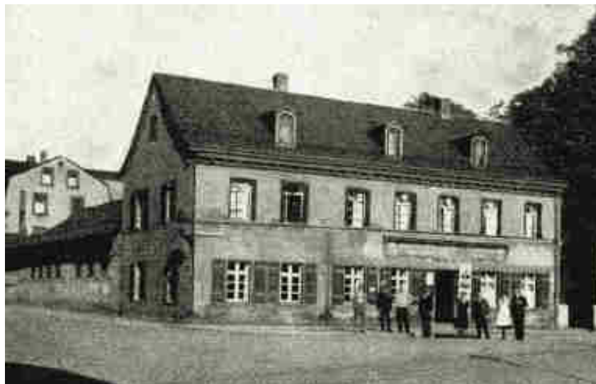
Ehemalige Gaststätte Treter (später Gutmann) am jetzigen Plärrer.
