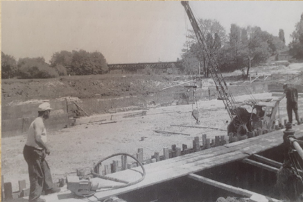
1968 Erdarbeiten zum neuen Bad, Quelle Mitteilungblatt 2007 Heft August, S. 31
