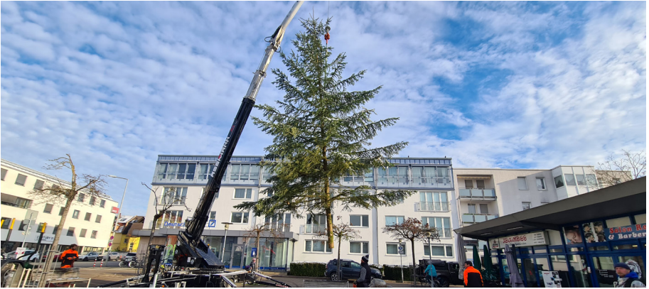
Per Kran wird der Baum in die geöffnete Bodenhülle gehoben.
